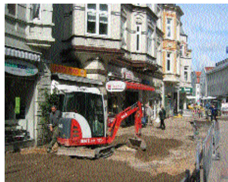
Die Umbauarbeiten haben begonnen, Mai 2003
