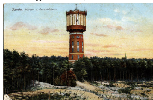
Der Lohbrügger Wasserturm, um 1910
