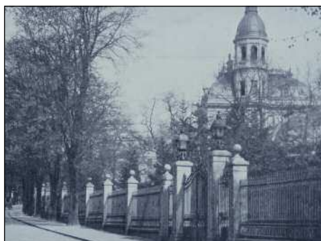
Villa Messtorff an der Wentorfer Straße
